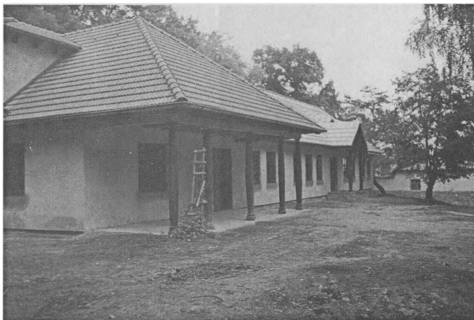
Jurczyce k. Krakowa – odbudowany dworek Hallerów
